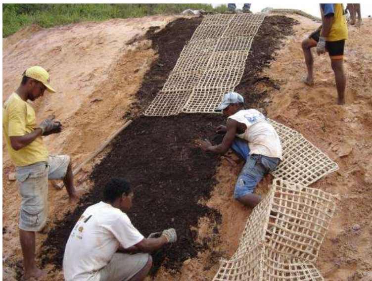
Figura 07: Aplicação dos geotêxteis e insumos.
