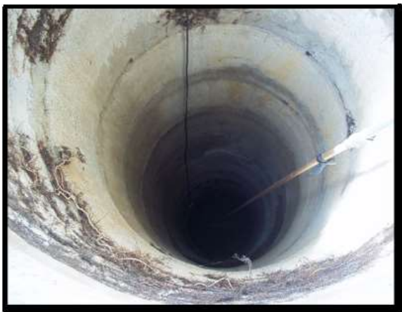
Foto 4: Poço cacimba individual (tubos de cimento) próximo ao Rio Maracanã.
