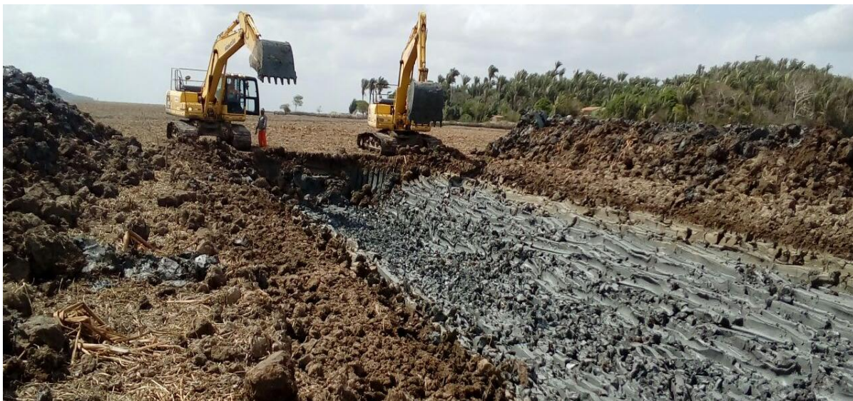
Foto 1 – Construção de canal na área dos campos inundáveis da área estudada
