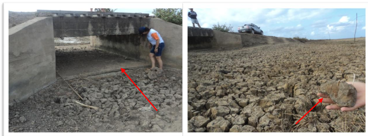
Figura 20 - Situação da Barragem Maria Rita construída na década de 1990
