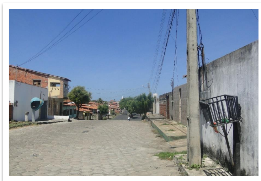
Figura 18. Pavimentação na sede de Tutóia
