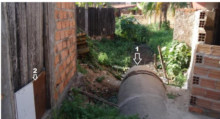
Foto 9 - Tubulações de esgoto implantadas no canal fluvial
