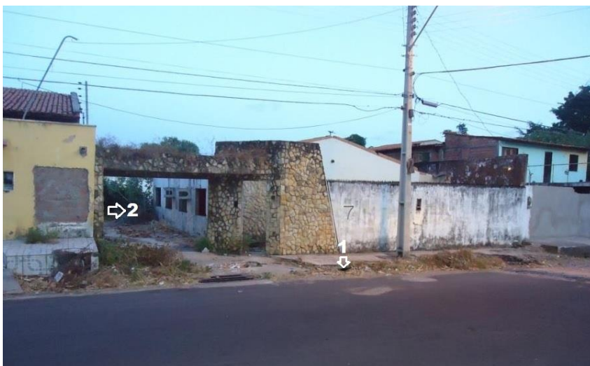
Foto 13 - Residência abandonada, após inundações
