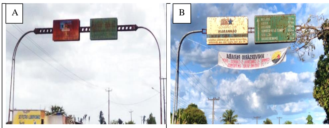
Figura 29: Placas indicativas de distância em precárias condições.
