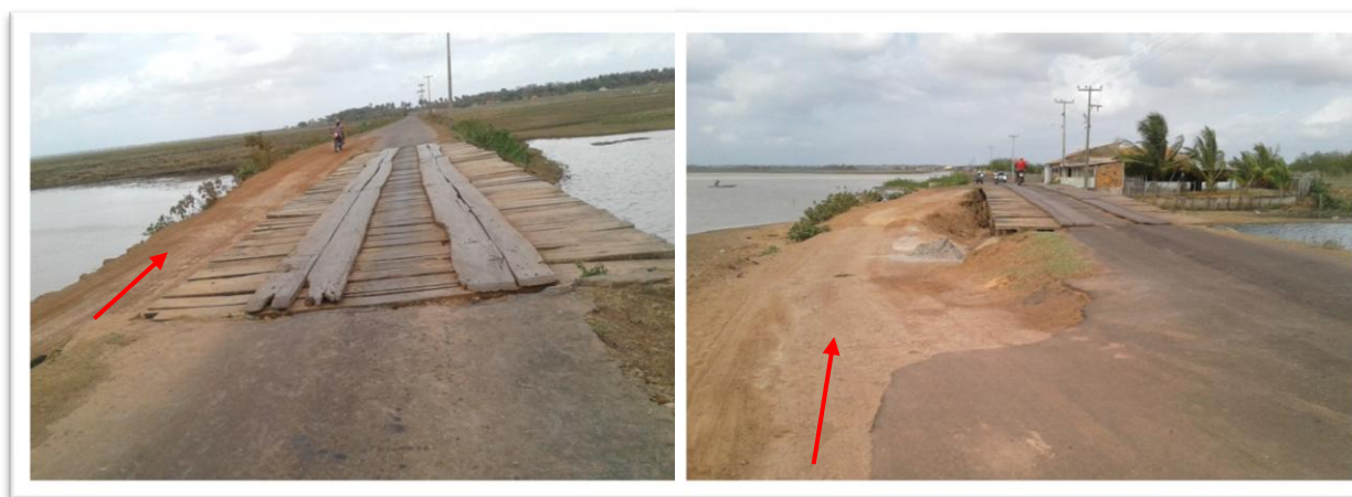
Figura 22 – Inserção de barramentos secundários: MA 310. Registro em 02/12/2016
