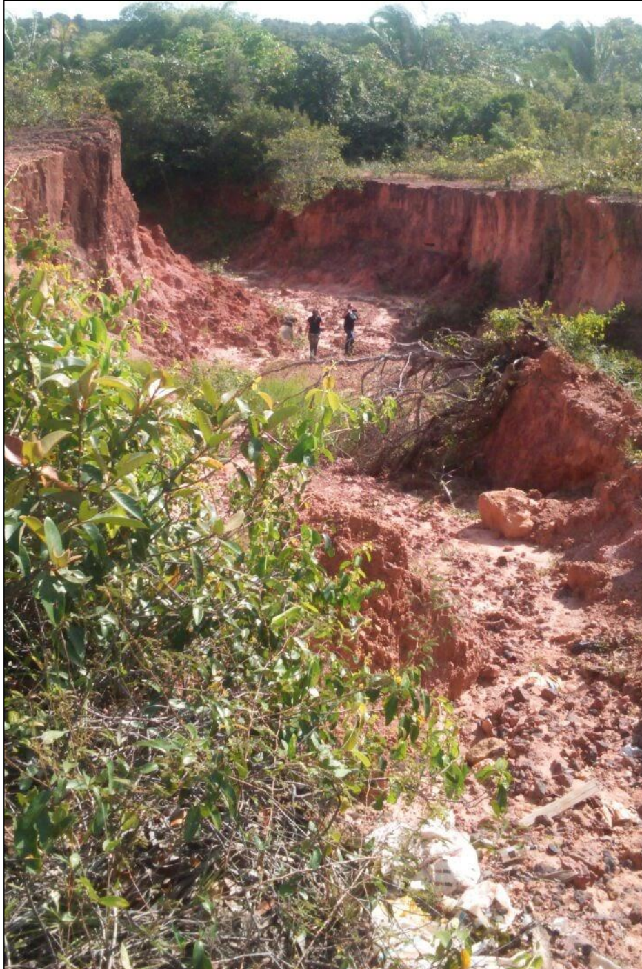
Figura 24 – Vista parcial da voçoroca 1 com presença de cobertura vegetal final do período chuvoso da região
