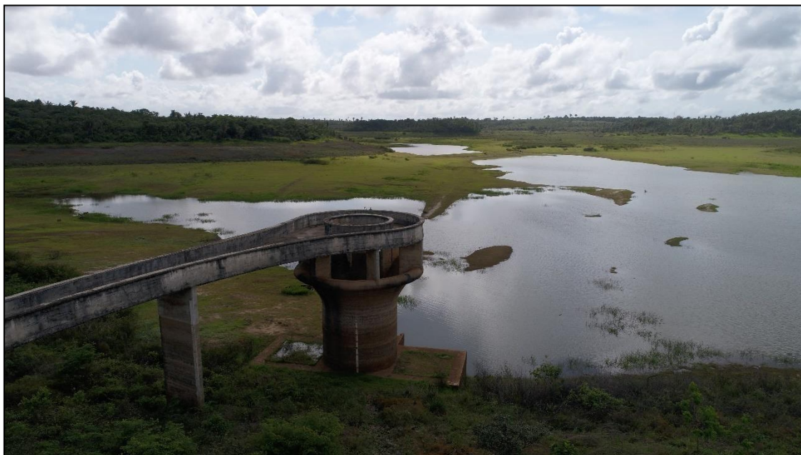
Figura 48 – Vista parcial do reservatório do Batatã, com seu volume morto atingido
