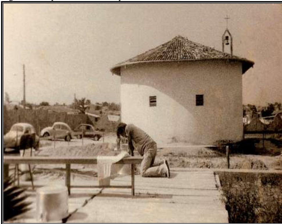
Figura 15: A parte de trás da capela.
