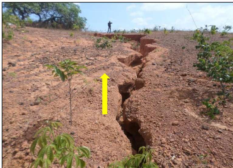
Figura 69 - Aspecto da voçoroca e presença de laterita
