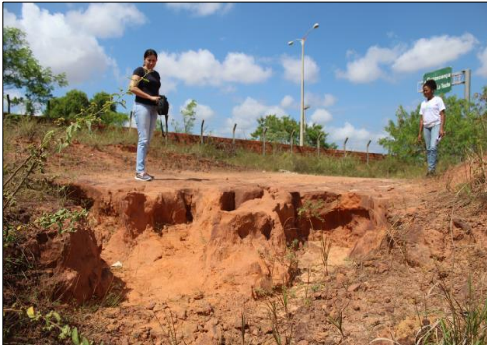
Figura 64 – Área de solo exposto
