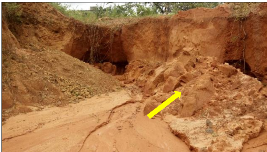
Figura 70- Movimento de massa e solapamento da base próximo a Voçoroca
