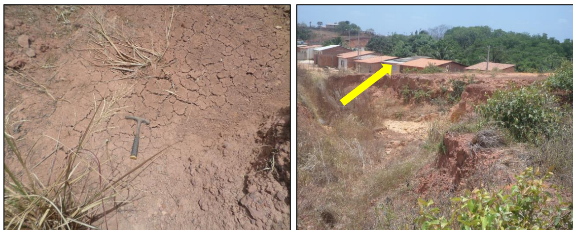
Figura 67 - Gretas de contração na superfície do solo e Voçoroca nas proximidades da comunidade do “Barreiro”
