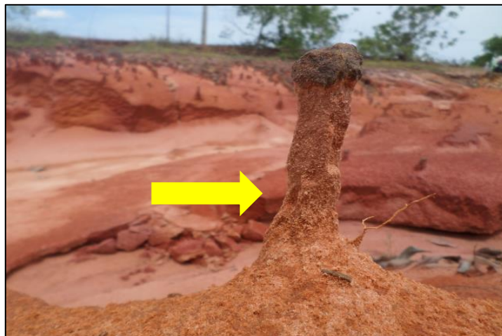
Figura 53 – Detalhe de pedestal ( demoiselles )
