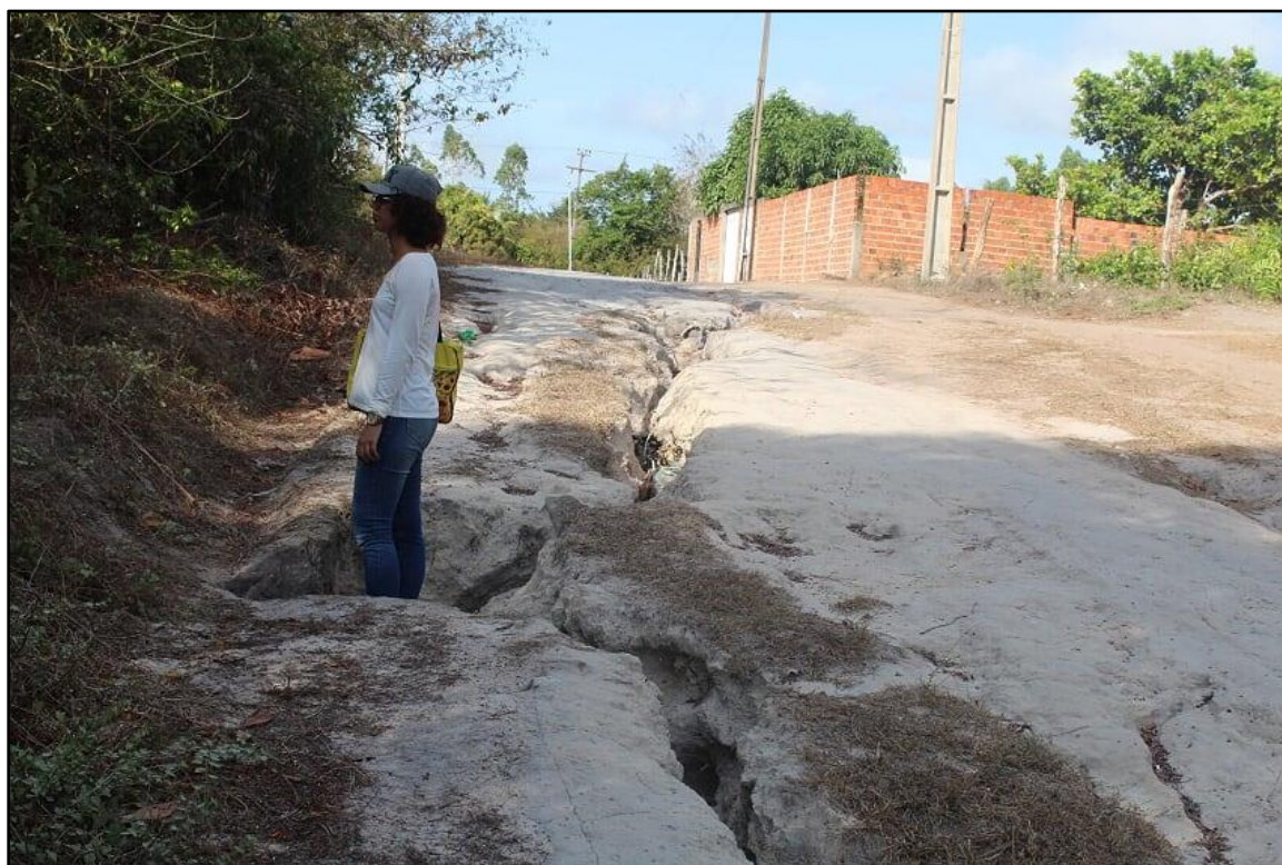
Figura 38 - Ravinamentos próximos ao leito do Boa Hora
