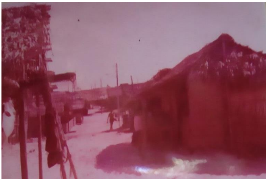
Figura 27 – Final da Avenida Principal de Raposa – MA em 1974.
