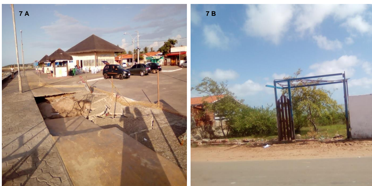
Figura 48 – Conseqüências da Inundação Costeira no Ponto 7, Raposa – MA, 2019.
