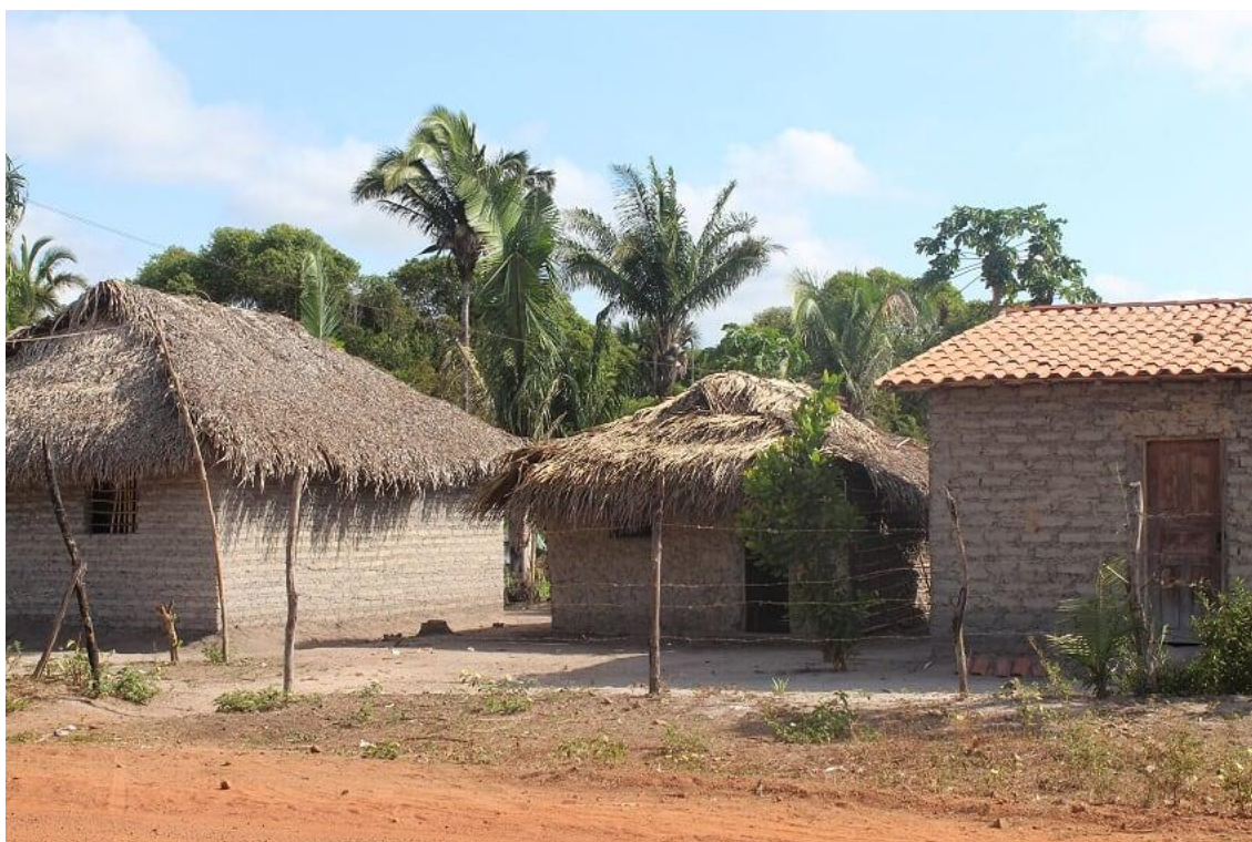
Figura 50- Moradia às margens da MA-025 na BHRBH
