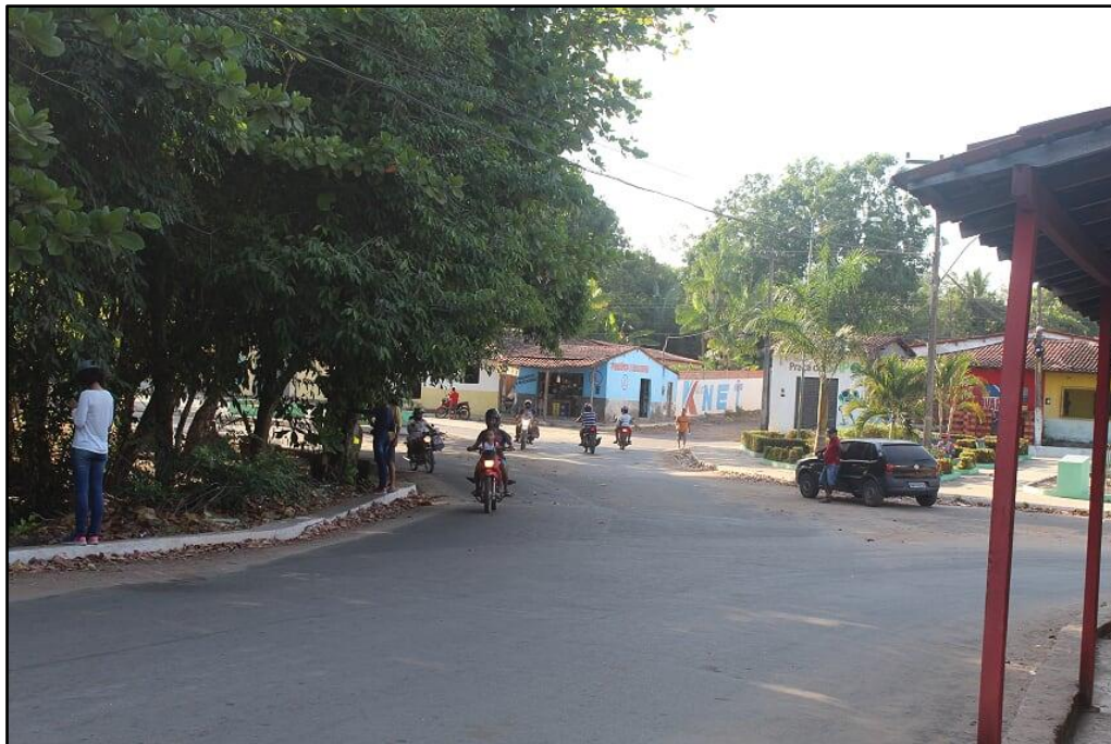
Figura 35 - Pavimentação asfáltica e impermeabilização do solo no bairro da Queimada
