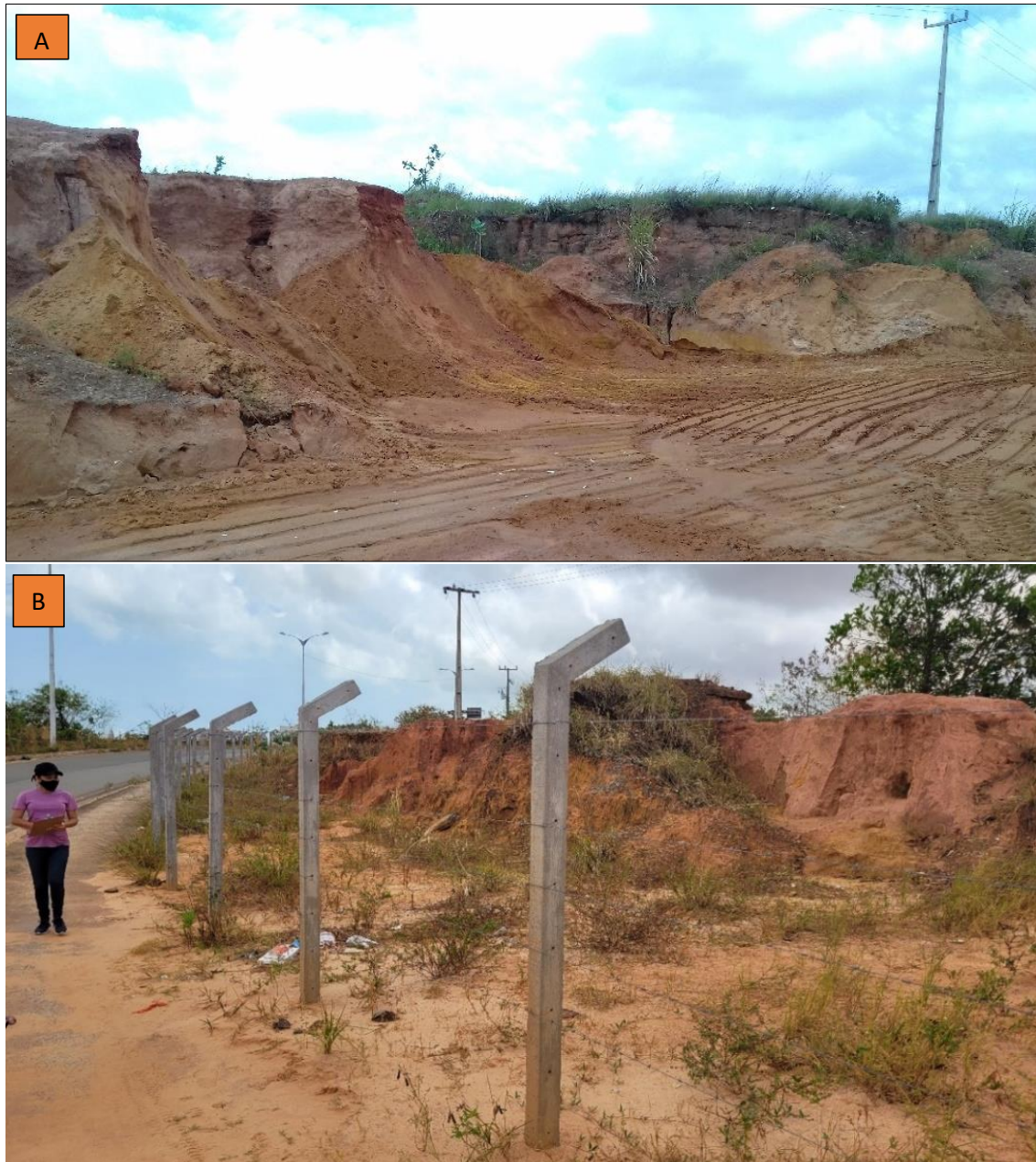
Figura 35 - (A) Terreno com feições induzidas, às Margens da Via Expressa e escavação de material sedimentar em 2018; (B) terreno com feições induzidas e revolvidas, às margens da Via Expressa, de material sedimentar movimentado em 2021
