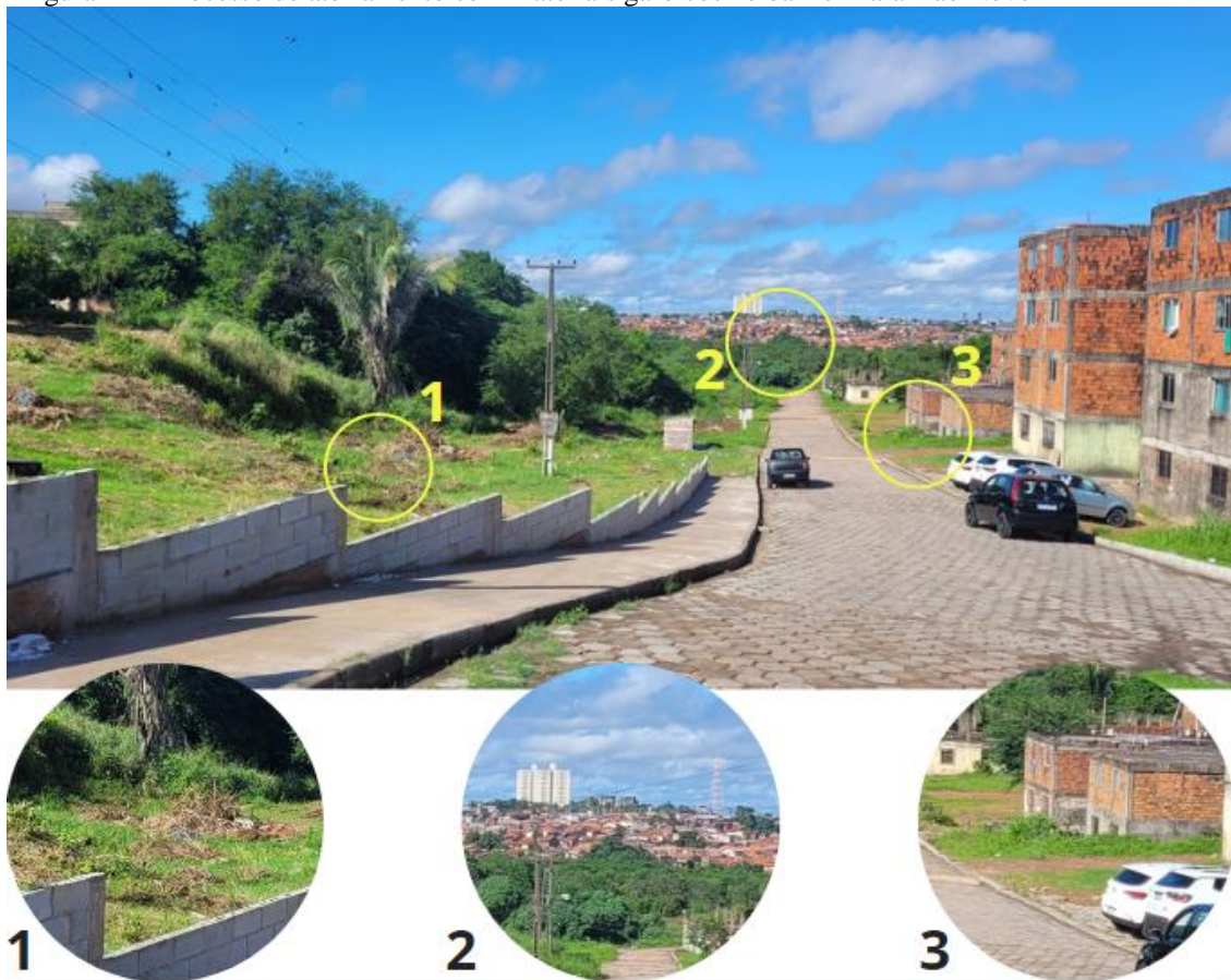
Figura 41 – Processo de aterramento com materiais gárbicos no bairro Maranhão Novo
