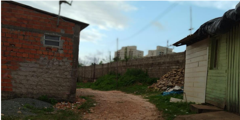
Figura 28 - Casas de alvenaria sob aterro com materiais gárbicos advindos do antigo lixão da cidade
