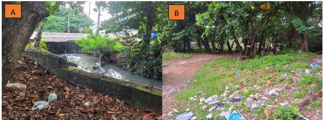
Figura 37 - (A) Lançamento de efluentes, no canal de drenagem do rio Anil, localizada na Curva do Noventa; (B) Área de bota-fora, às margens do canal de drenagem do rio Anil, na Curva do Noventa no ano de 2022
