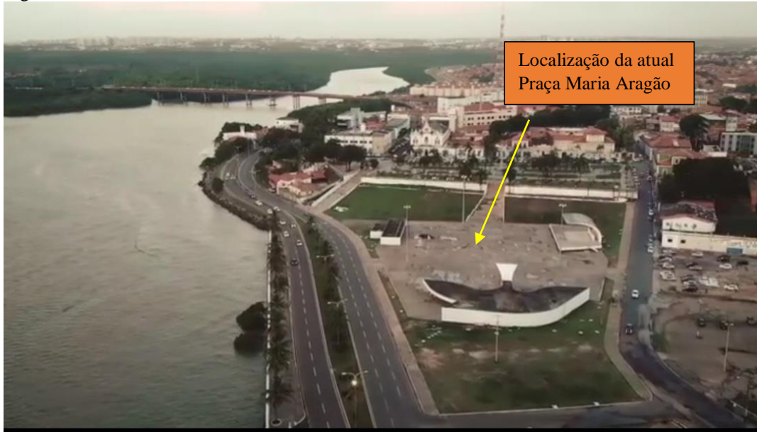
Figura 22 - Avenida Beira Mar, denominada como terreno urbanizado de corte-aterro
