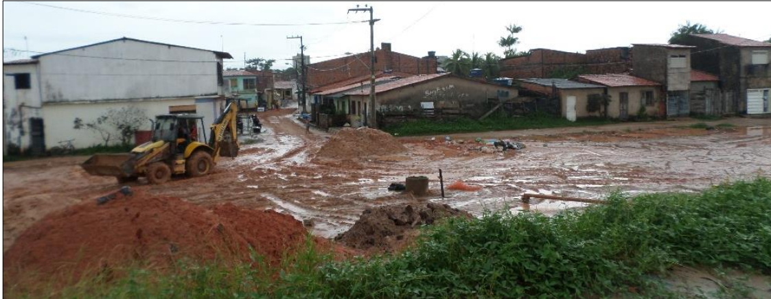
Figura 30 - Processo de terraplenagem para a construção da Avenida IV Centenário sobre a planície tecnogênica mista
