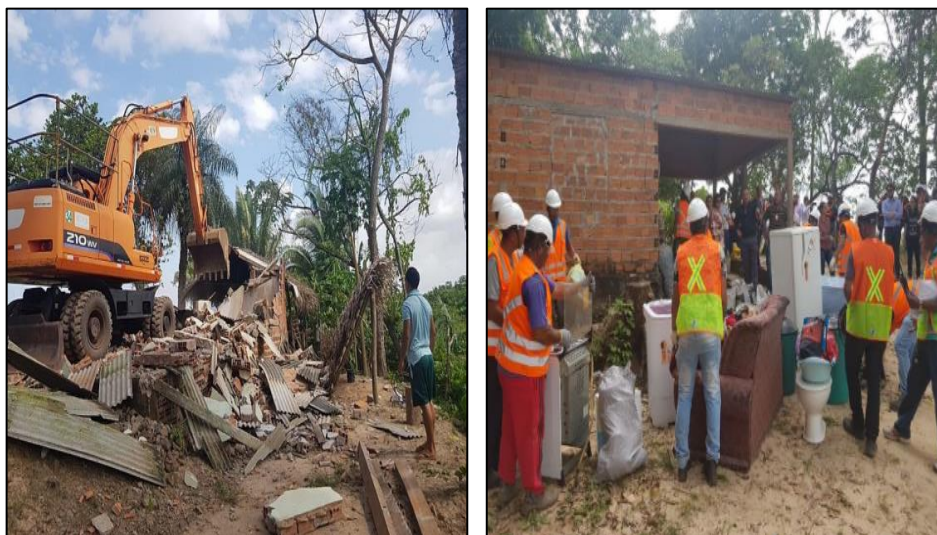
Figura 21 – Derrubada de moradias no Cajueiro
