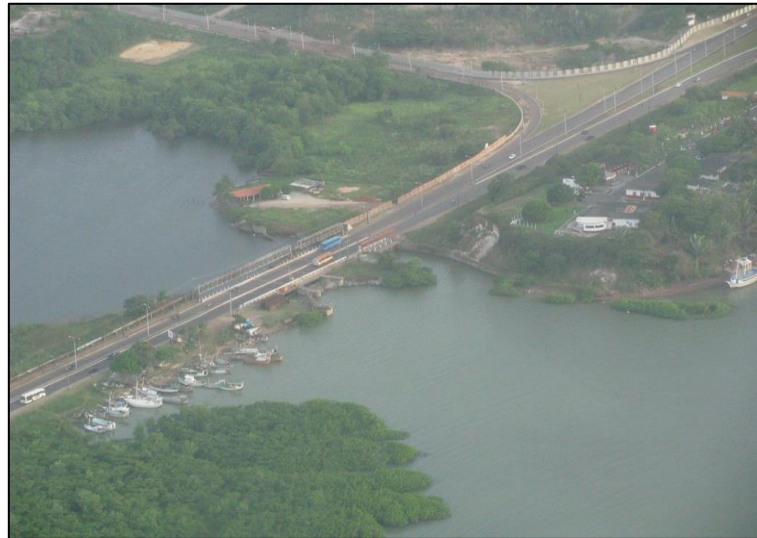
Figura 3 – Barragem do rio Bacanga
