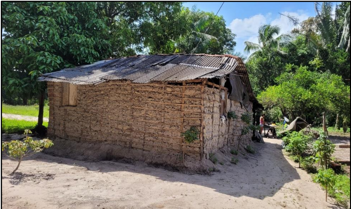
Figura 14 – Casa de taipa, Rua do Porto, Tendal Mirim
