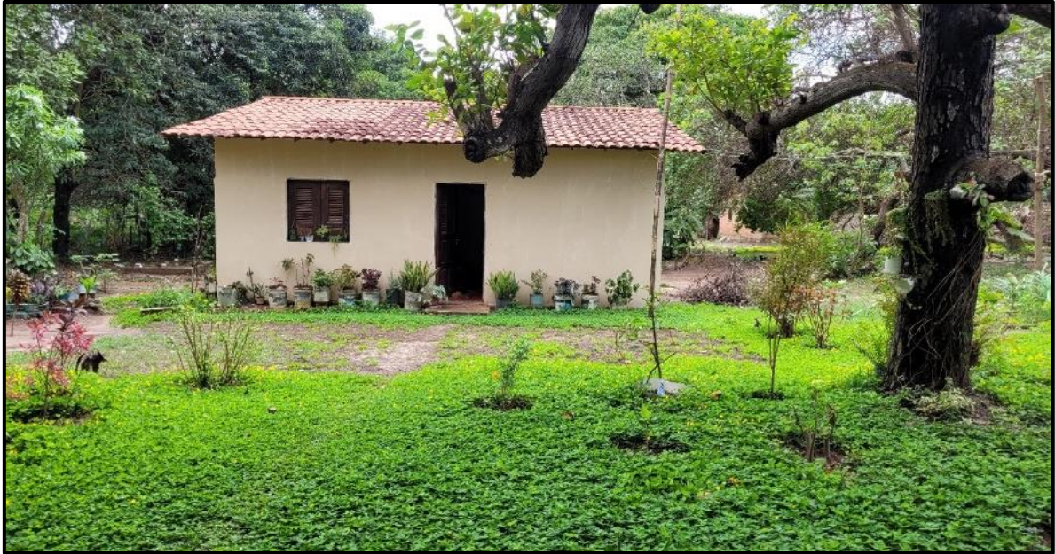
Figura 13 – Casa em alvenaria, Rua Principal, Tendal Mirim
