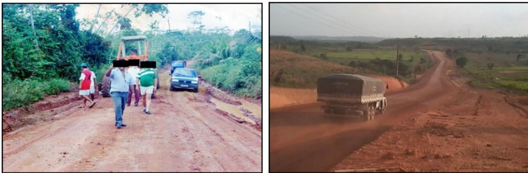
Figura 4 – Rodovia PA-124, trecho Garrafão do Norte/Nova Esperança do Piriá (1996)
