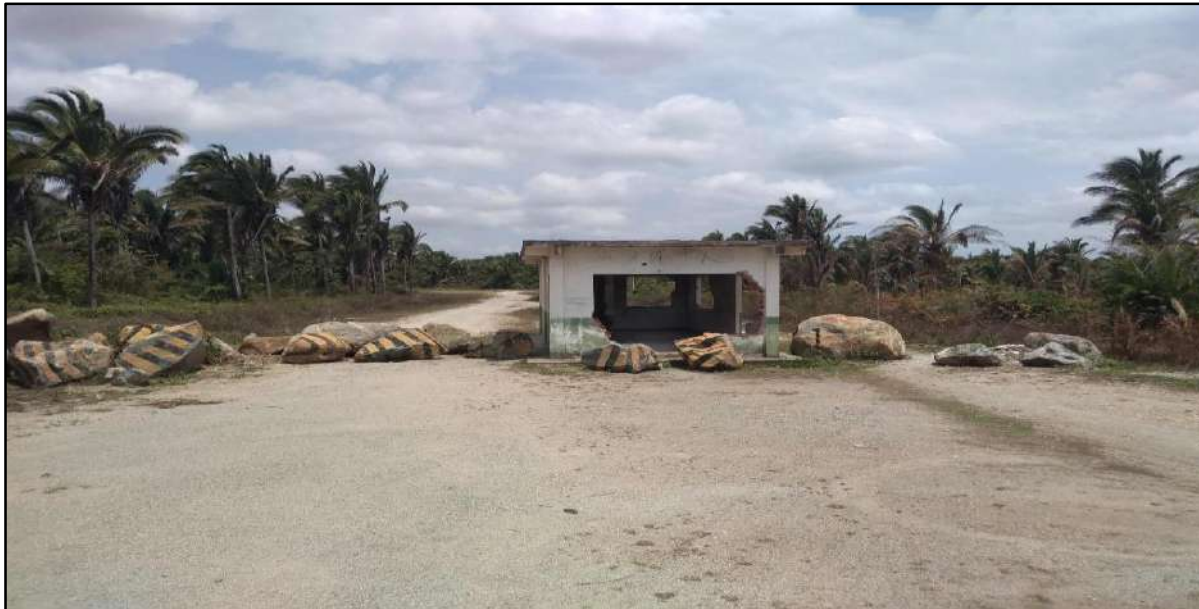
Figura 70 - Entrada da Pedreira no Município de Rosário.
