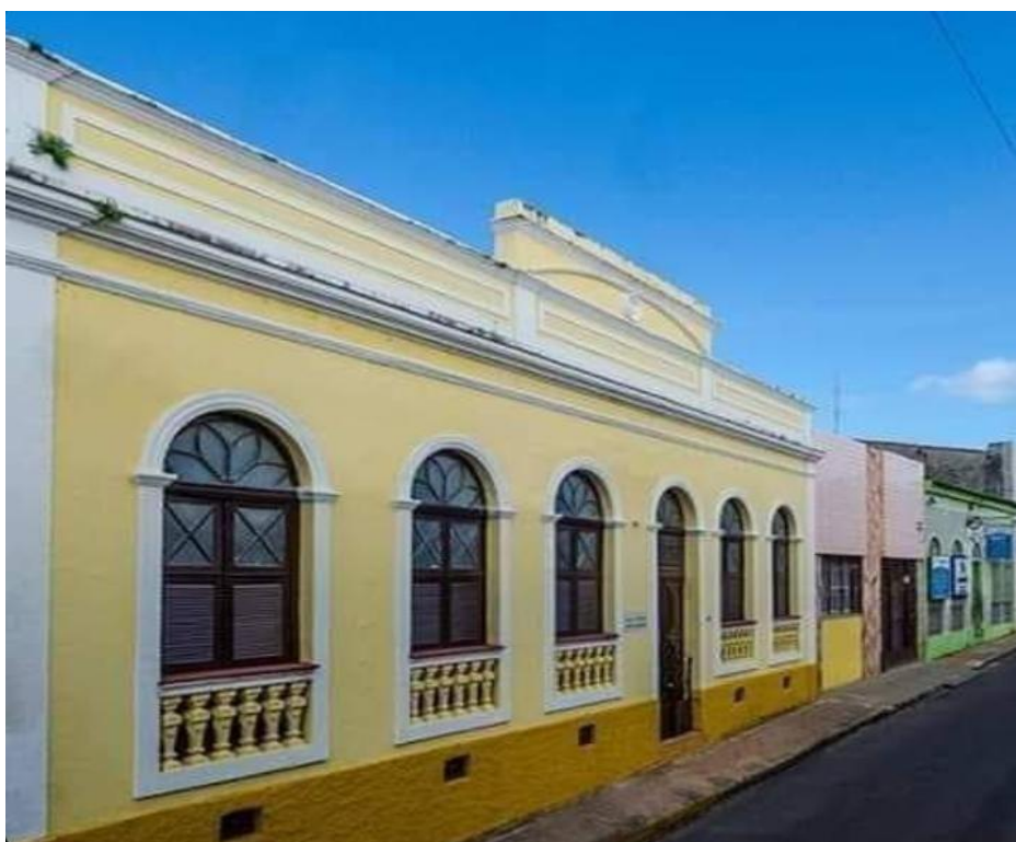
Figura 2 - Fachada da Casa de Cultura Josué Montello
