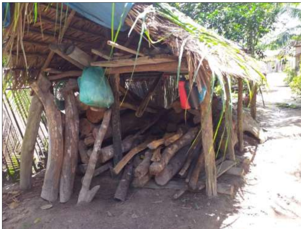
Figura 33 – Armazenamento de lenha em quintais
