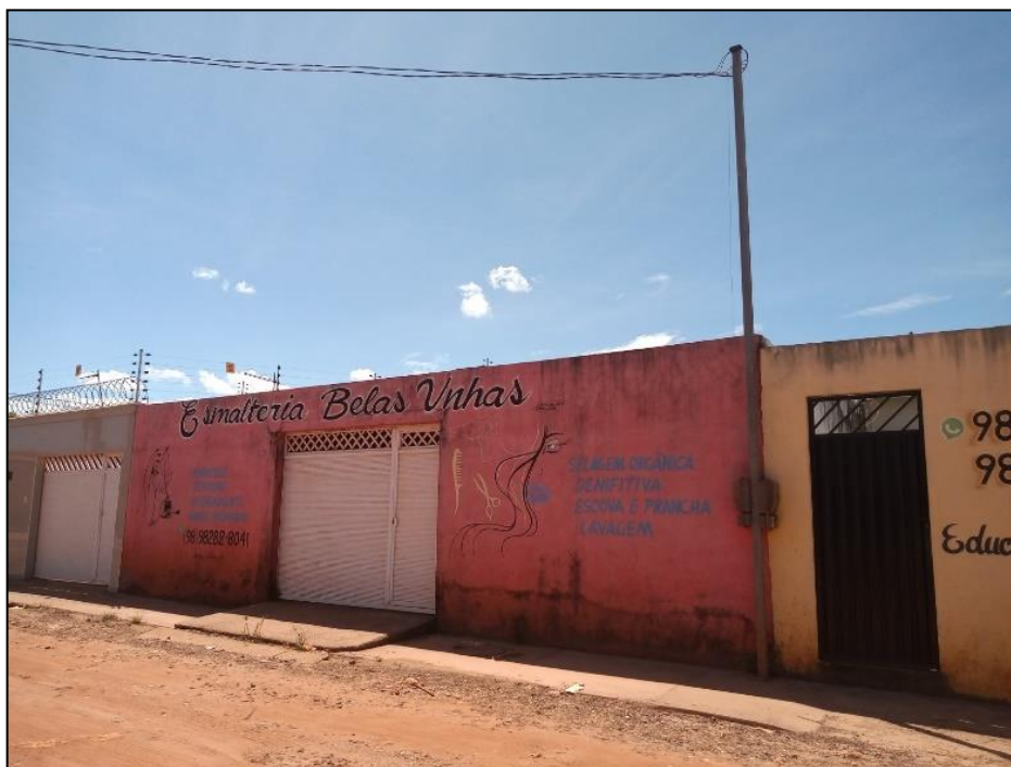
Figura 21 - Estabelecimento improvisado, ainda com estrutura residencial
