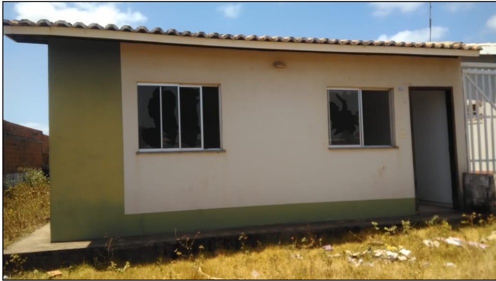
Figura 19 - Residência abandonada e depredada no RCV I
