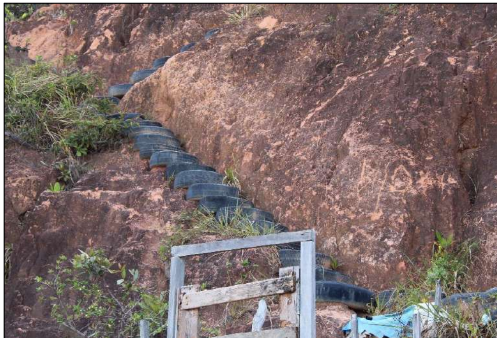
Figura 12 - “Escada de pneu”.
