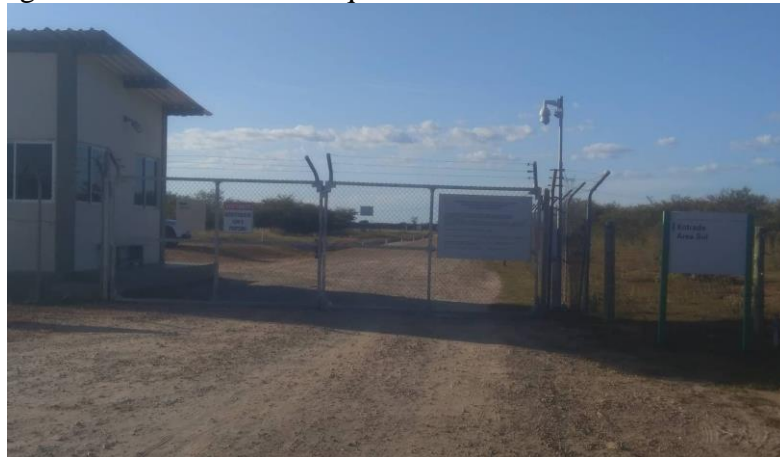
Figura 34 – Entrada do Parque Solar Nova Olinda em Ribeira do Piauí/PI
