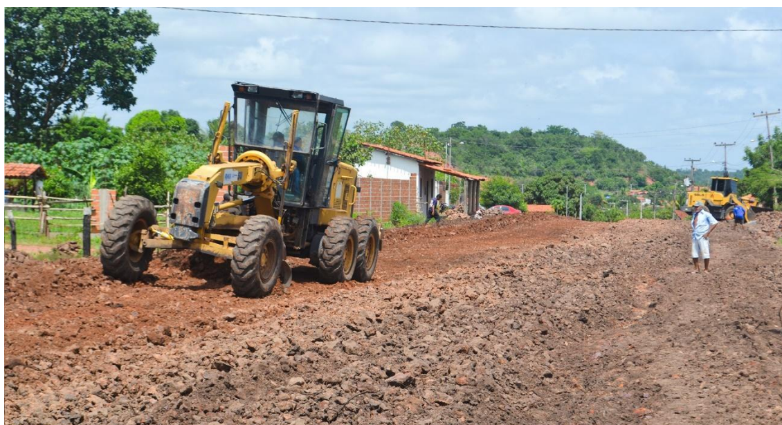
Figura 18: Construção da nova avenida da cidade, “novo cartão postal”
