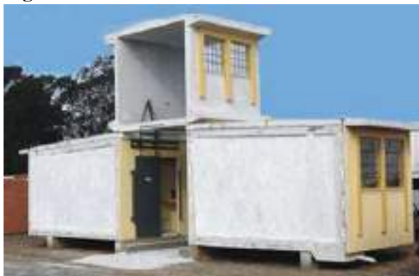
Figura 6 – Estrutura dos módulos
