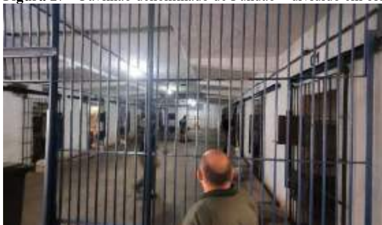
Figura 27 – Pavilhão denominado de Fundão – dividido em blocos (2023)
