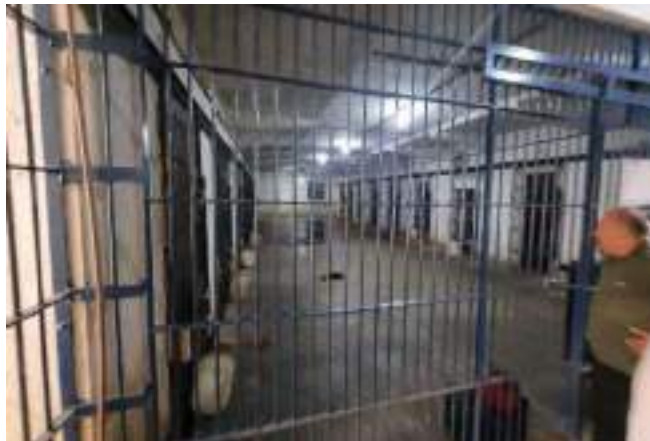
Figura 17 – Pavilhão denominado de Fundão – dividido em blocos (2023/2024)
