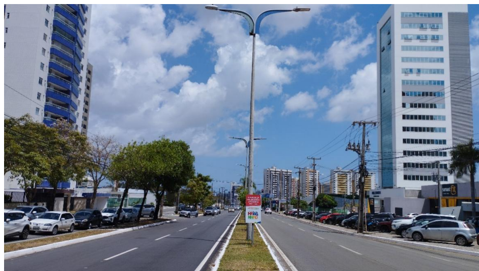
Figura 28 - Avenida dos Holandeses sentido centro na altura do edifício da FECOMÉRCIO
