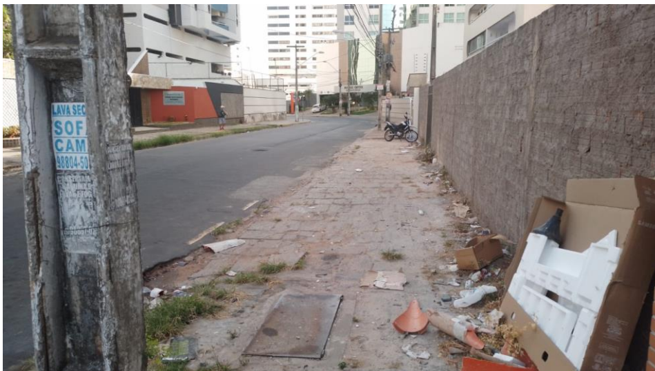
Figura 19 - Parte da infraestrutura viária do Renascença II com destaque para calçamento irregular e descarte irregular de lixo – Rua Mitras
