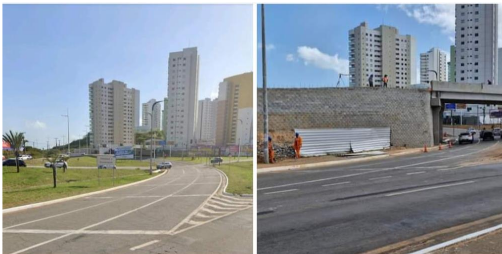
Figura 27 - Viaduto da Avenida dos Holandeses
