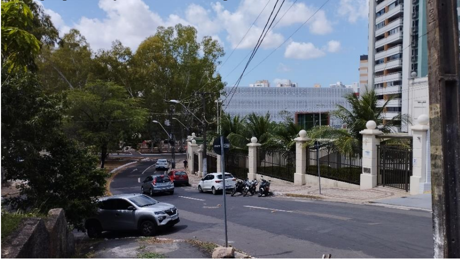
Figura 18 - Parte da infraestrutura viária do Renascença II com destaque para calçadas – Rua Olimpo
