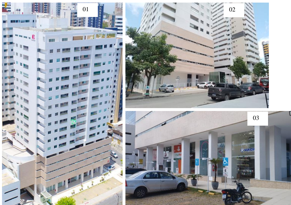
Figura 50 - Edifício Scarp no Renascença II
