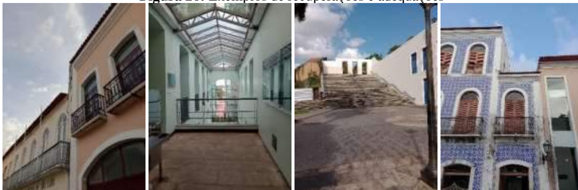
Figura 26: Exemplos de recuperações e adequações
