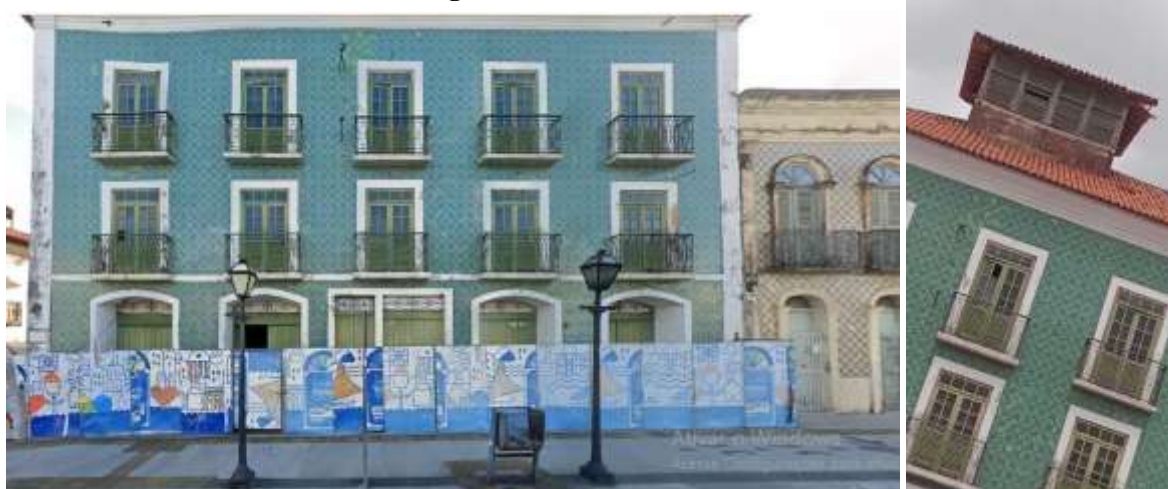
Figura 16: Solar dos Belfort
