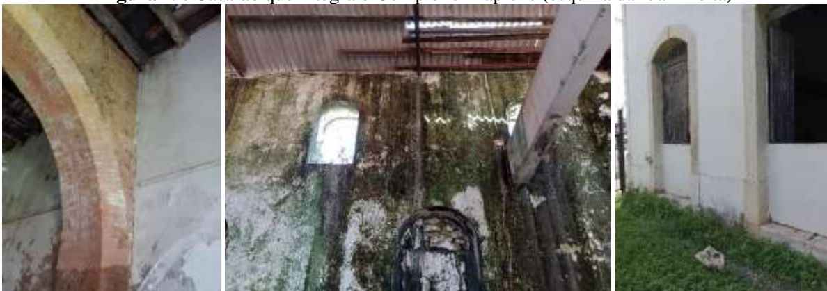
Figura 19: Casarão que integra o Complexo Trapiche (esquina da rua Direita)
