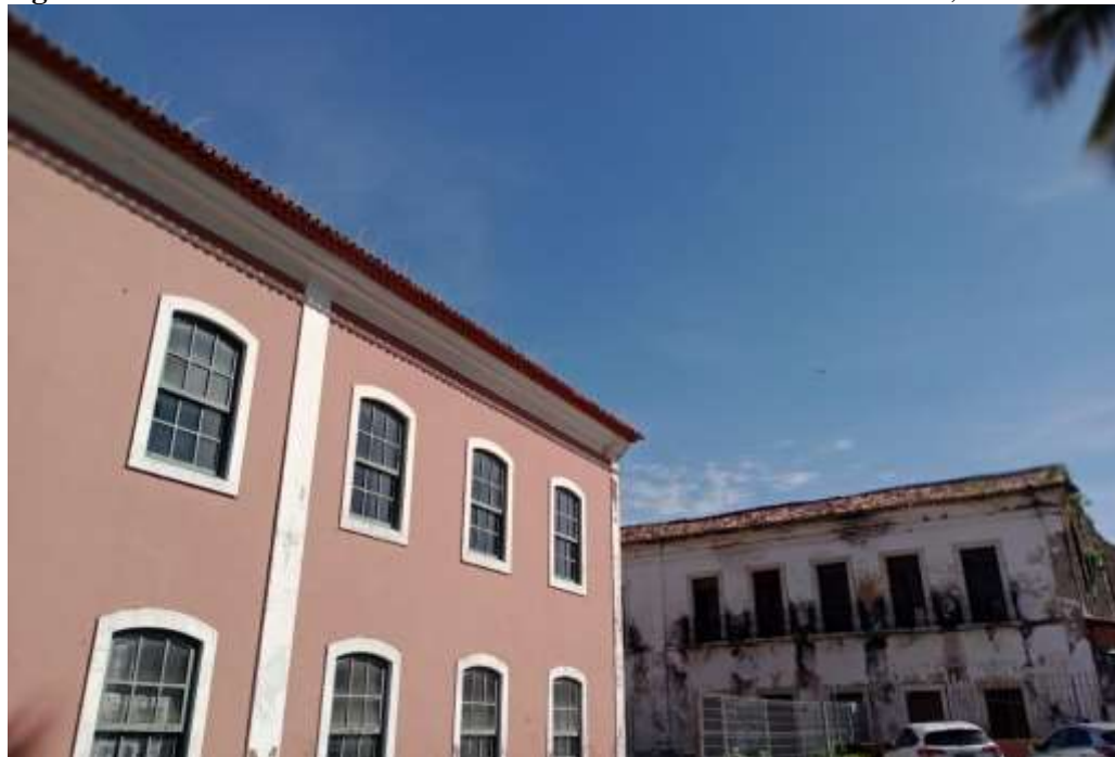
Figura 20: Contraste do Convento das Mercês e Prédio à rua Jacinto Maia, no Desterro
