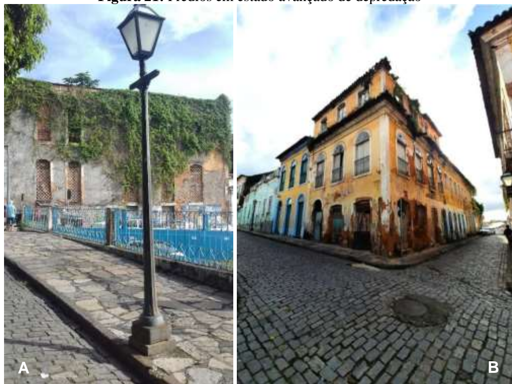
Figura 21: Prédios em estado avançado de depreciação
