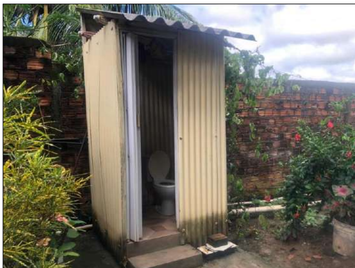
Figura 80 – Exemplo de banheiro com apenas o sanitário em domicílio no bairro Trizidela
