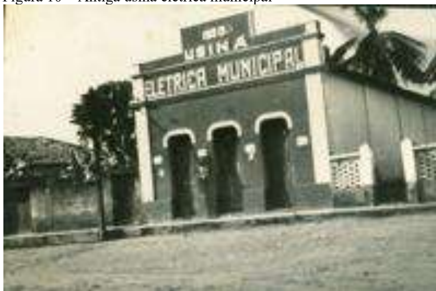
Figura 10 – Antiga usina elétrica municipal
