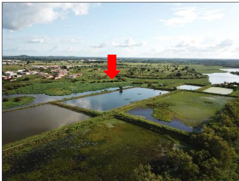
Figura 67 – Bacias de decantação para o tratamento de esgoto no bairro Novo Bacabal
