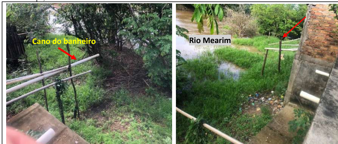
Figura 71 – Exemplo em que o tipo de destinação do esgoto doméstico é o rio, na rua Jorge Mendonça, bairro Trizidela
