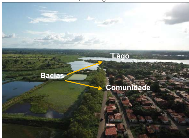
Figura 68 – Bacias de decantação para o tratamento de esgoto no bairro Novo Bacabal, e o Lago Brisa
