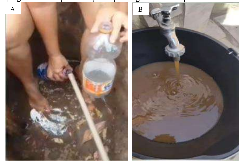
Figura 64 – A) Outras formas de acesso à água encanada em domicílios de Bacabal; B) Água de coloração inadequada que chega às torneiras pelo sistema SAAE
