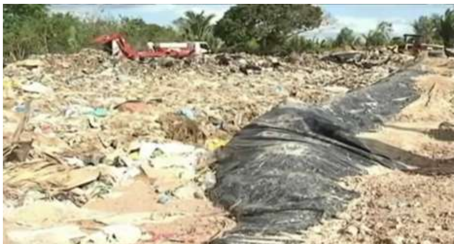
Figura 23 - Aterro controlado com mantas perfuradas.
