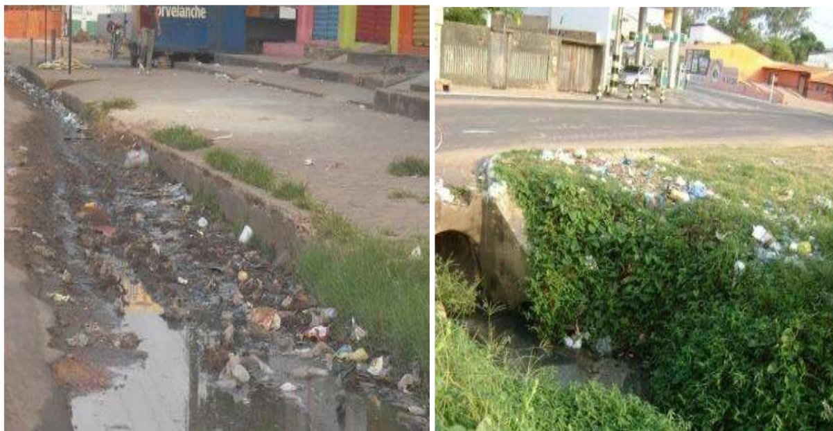
Figura 18 - Ponto: Disposição inadequada dos resíduos em Santa Inês - MA.
