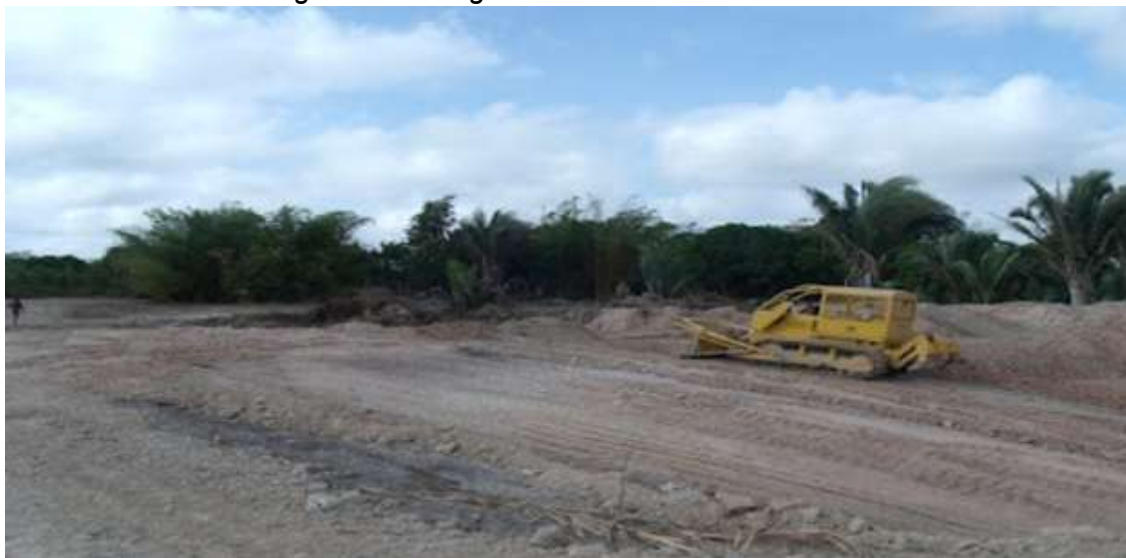
Figura 21 - Imagem do aterro controlado em 2013.
