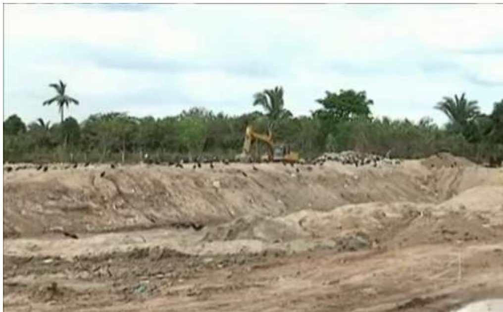
Figura 22 - Valas de preparo para o novo aterro controlado.
