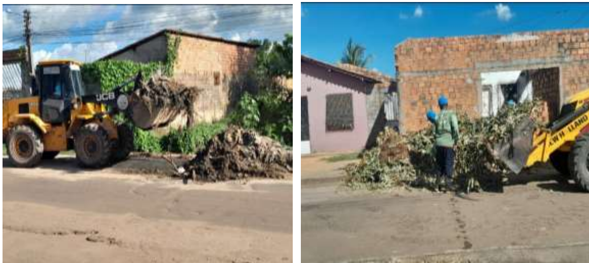
Figura 41 - Remoção mecânica de resíduos em ponto de descarte irregular na Av. Brasil, no bairro Mutirão
