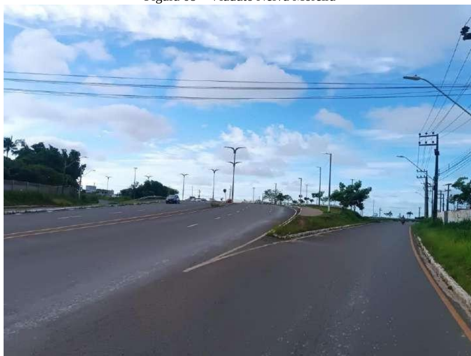
Figura 68 – Viaduto Neiva Moreira
