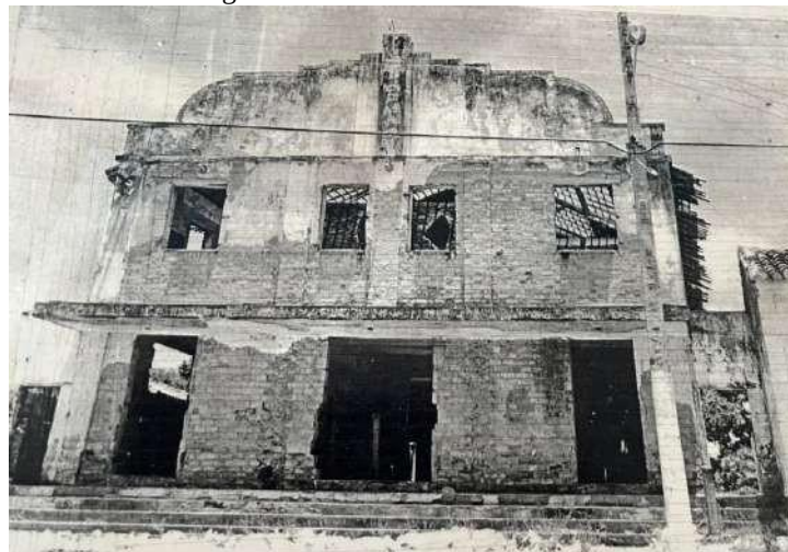
Figura 10 – Cine Ribamar em ruína
