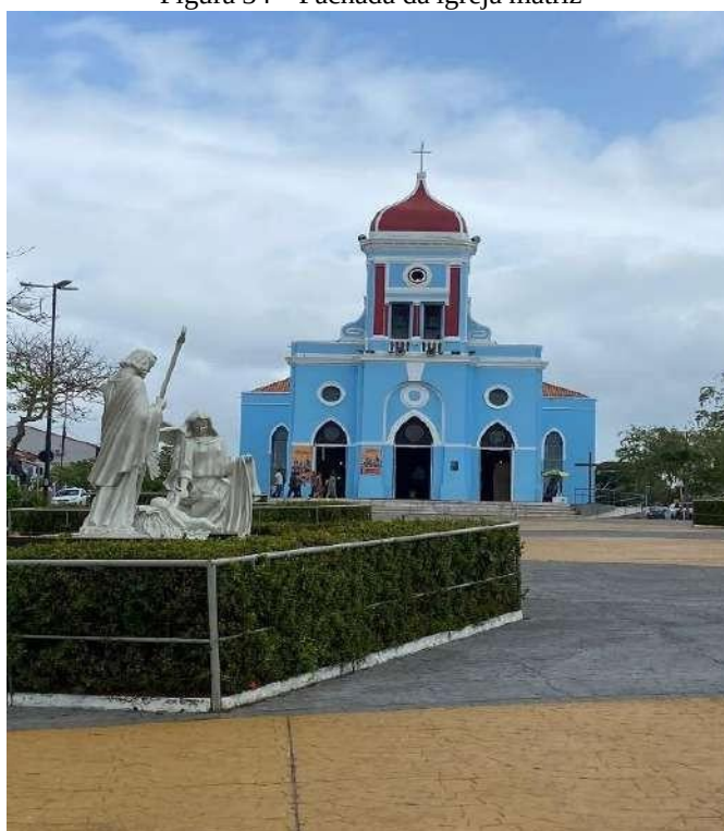
Figura 34 – Fachada da igreja matriz
