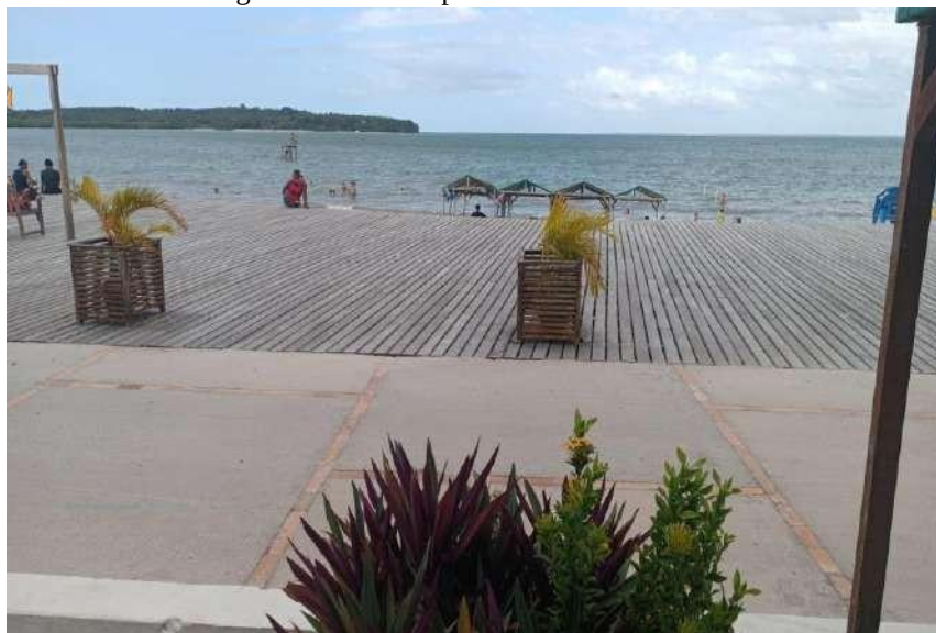
Figura 53 – Píer na praia de banho atualmente
