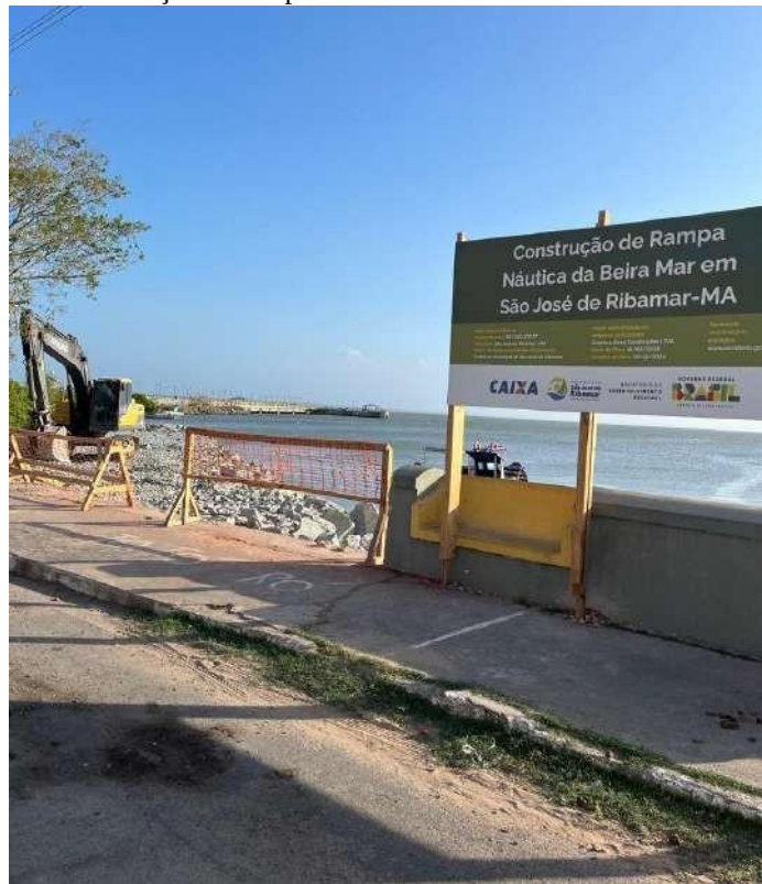
Figura 54 – Construção de rampa náutica da Beira Mar em São José de Ribamar
