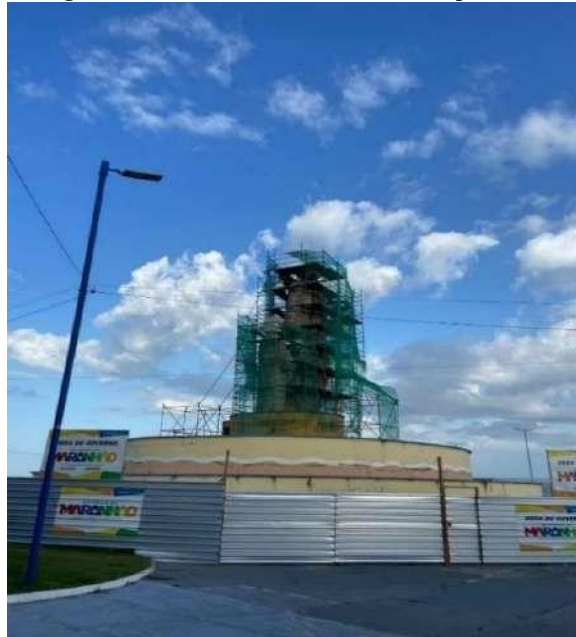
Figura 42 – Monumento com estrutura protetora
