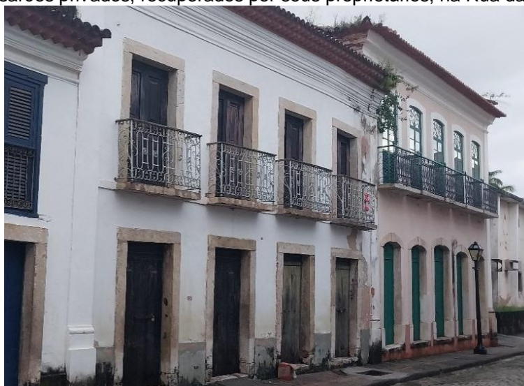
Imagem 46: Casarões privados, recuperados por seus proprietários, na Rua da Estrela, Desterro
