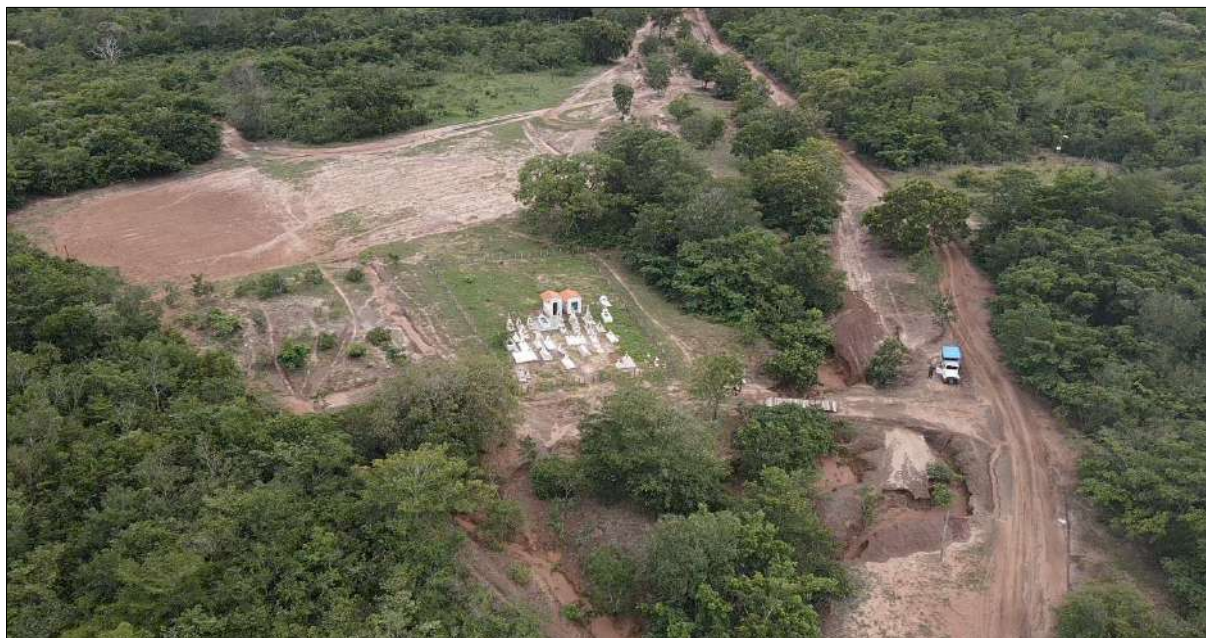
Figura 65: Solo exposto e processo erosivo nas proximidades do povoado Vereda 3.
